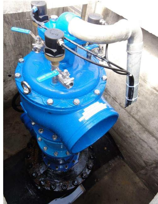
*Ventosa Dinámica D-070 de ARI. A la izquierda instalada sobre candelabro. A la derecha el modelo DN300 con cuatro (4) purgadores en la parte superior.*
