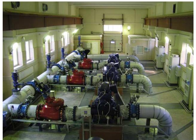
*Válvulas de retención controladas hidráulicamente. El motor hidráulico controla el tiempo de cierre de la clapeta.*
