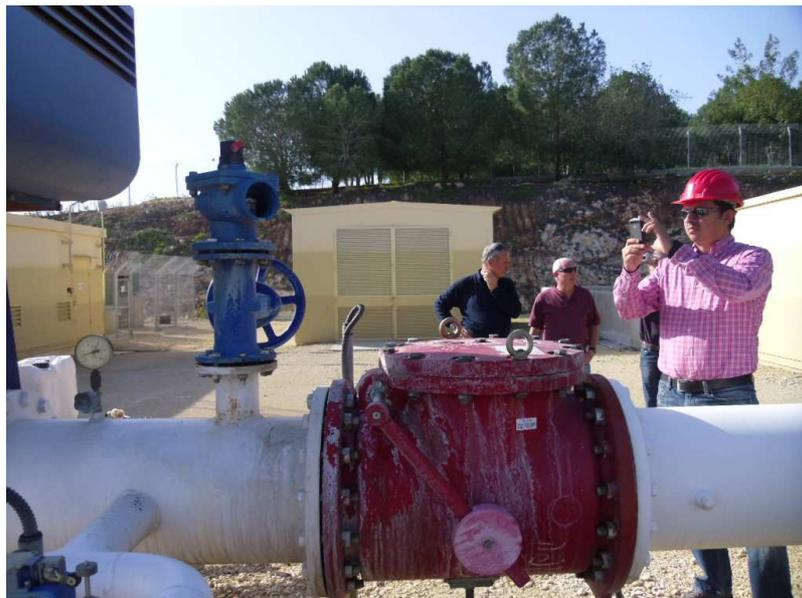
Bomba de pozo profundo con ventosa de efecto dinámico D-070 de ARI instalada.
