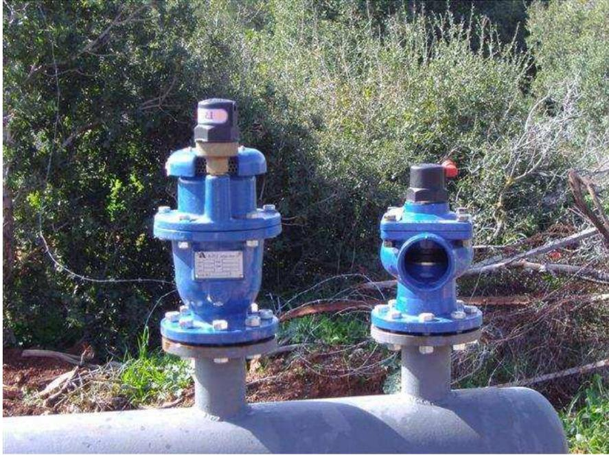
*Ventosa antiarriete de 3 etapas D-060NS a la izquierda. Ventosa de efecto dinámico D-070 a la derecha. Ambas instaladas en un final de línea.*
