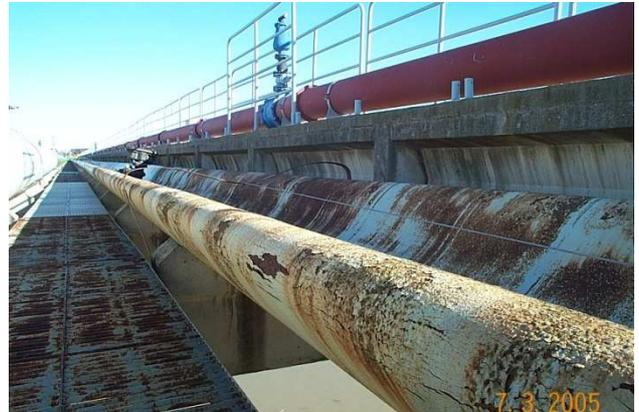
*Tubería de acero aplastada por colapso debido a presiones negativas en su interior.*
