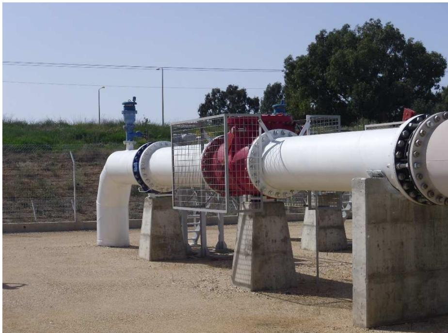
*Ventosa de cierre en 3 etapas de ARI Flow Control Acc. Modelo D-060NS a la salida de una estación de bombeo.*
