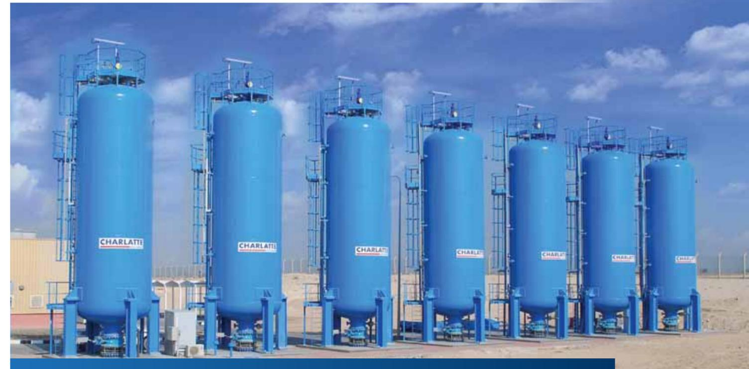
*Tanques de vejiga para sistemas de agua potable*
